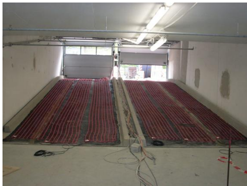
Verlegung der Freiflächenheizung
