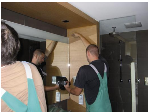
BU: Installation der Spiegel inklusive vormontierter AEG Spiegelheizung im Hotelbad durch das Glaszentrum Wissmar
