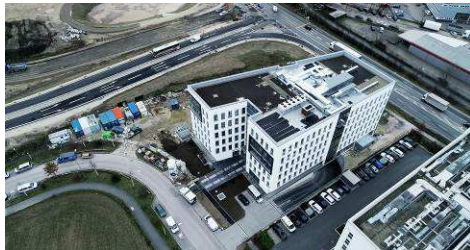
(01_AEG Raiba-Center Luftbild.jpg)
