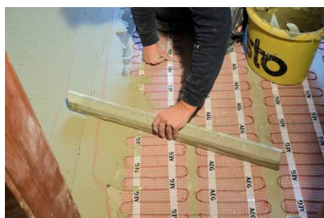
13 AEG Badrenovierung Ausgleichen.jpg
