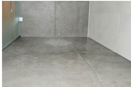
02a AEG Badrenovierung Dusche neu.jpg
