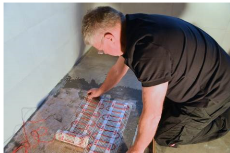
07 AEG Badrenovierung Heizmatte Dusche.jpg
