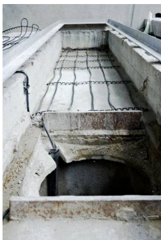
05_AEG_DIC in Ablaufrinne.jpg
