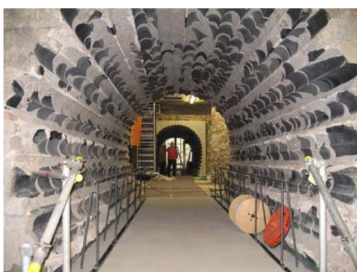
BU: Neu gebohrter Tunnel
