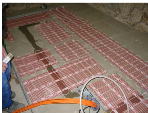
BU: Fertig verlegte Heizmatte
