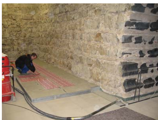
BU: Monteur der Firma Baeth bei der Verlegung des AEG
