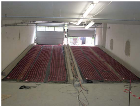
Verlegung der Freiflächenheizung
