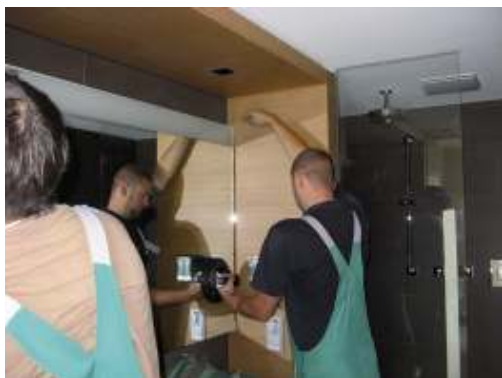
BU: Installation der Spiegel inklusive vormontierter AEG Spiegelheizung im Hotelbad durch das Glaszentrum Wissmar
